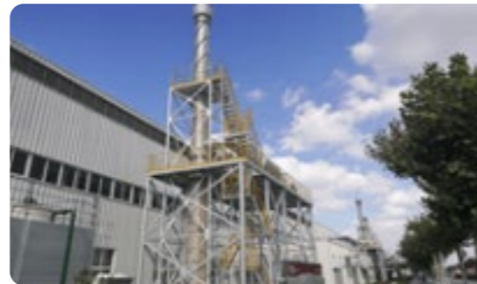
完成试车废气治理设施的建设及投用
