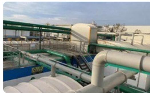
对高新园区污水站恶臭气体进行收集和治理，确保污水站无恶臭气体逸散
